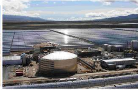
الشكل (2) تقنية المركّزات الشمسية ذات القطع المكافئ الاسطواني.
