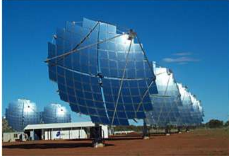
الشكل (1): تقنية المركّزات الشمسية ذات القطع المكافئ الدائري.
